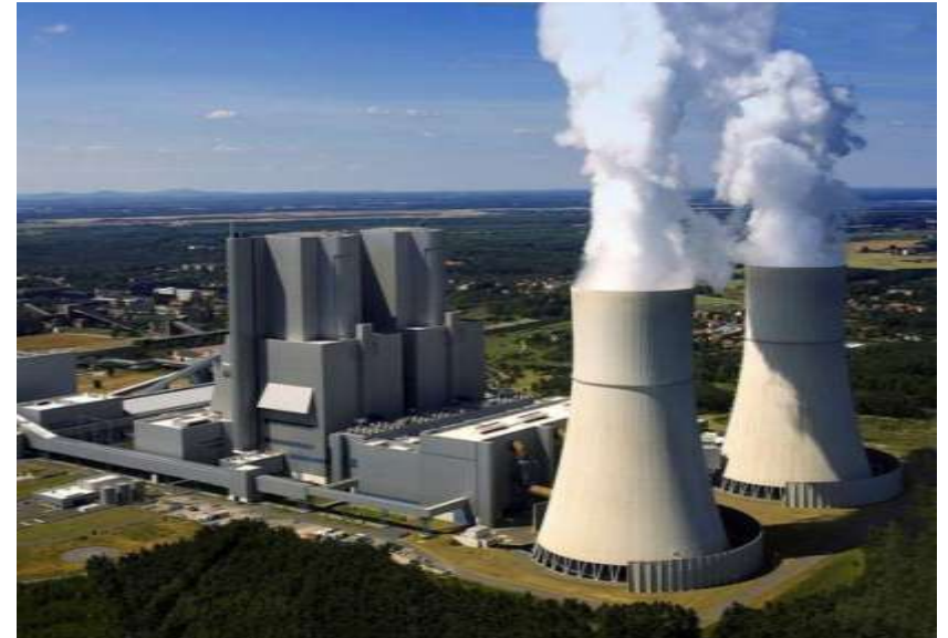
Braunkohlekraftwerk Schwarze Pumpe; Quelle: idw
